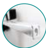
Fissaggio della struttura al muro
